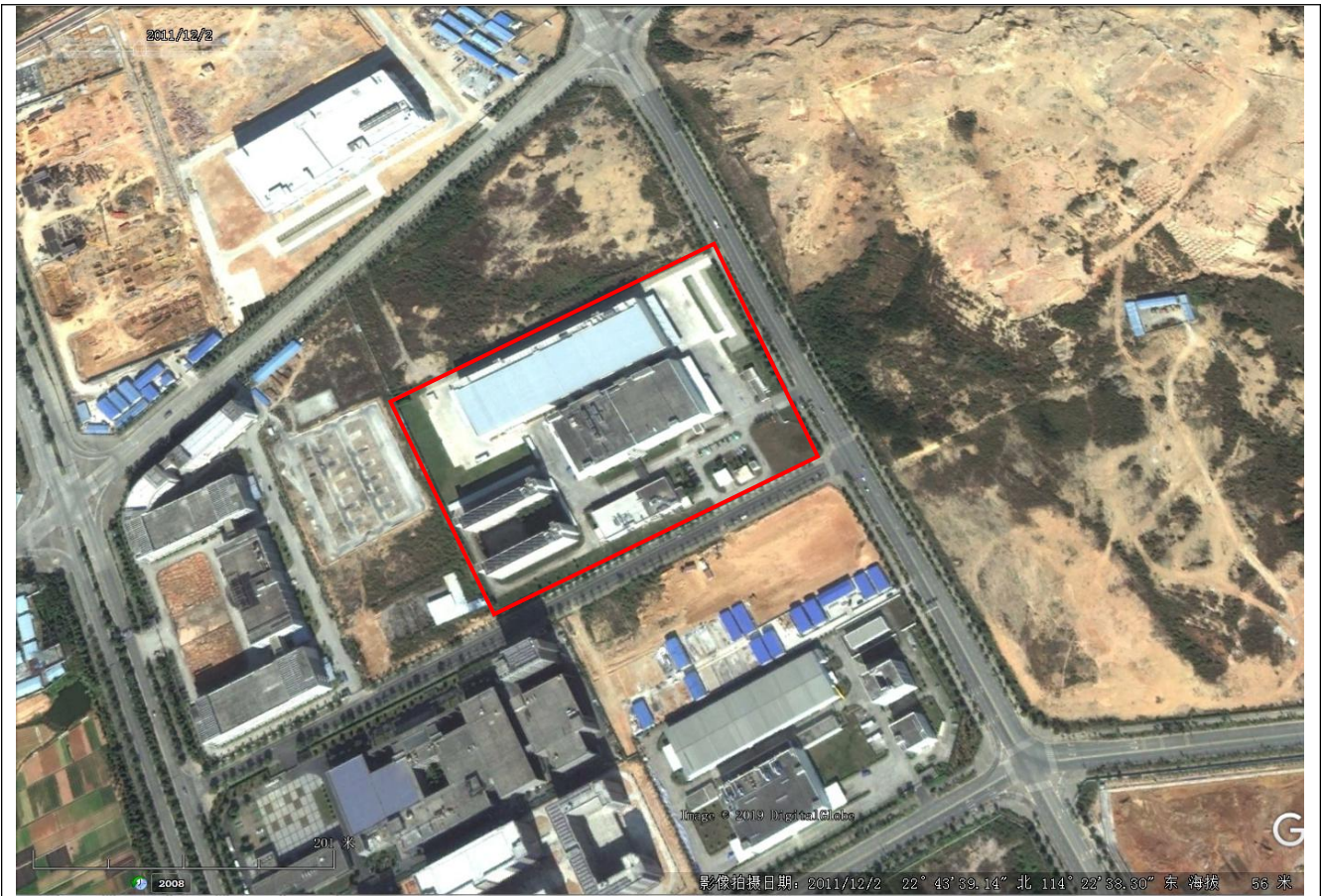
2011 年 12 月，项目建筑内 B 栋已建设完成，南面隔聚龙山七号路为施工营地，其余无变化
