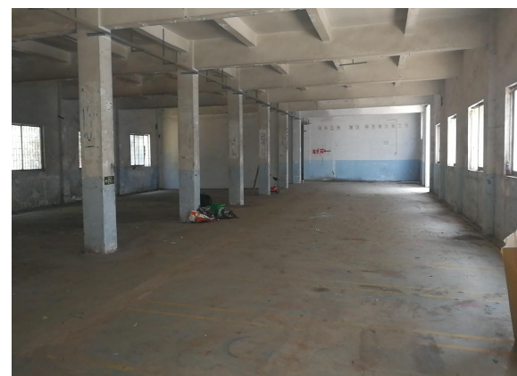
项目车间现状
