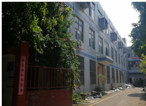
项目北面工业厂房
