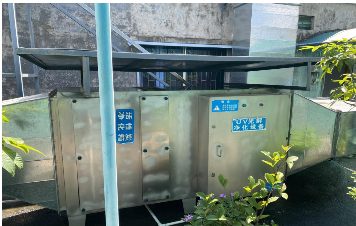
UV 光解+活性炭吸附废气处理装置
