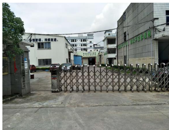
项目厂房现状
