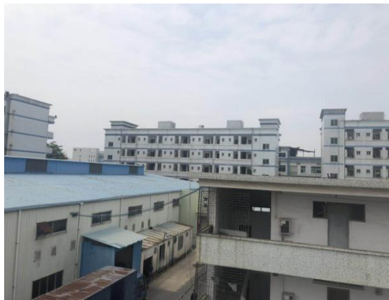
项目北面工业厂房及宿舍楼
